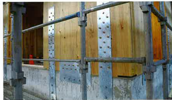
図6 基礎とCLTパネルの接合
