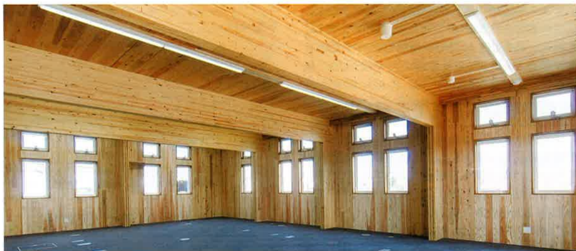
図2 事務所棟の内装はCLTパネルを現しで用いて木質感あふれる空間を演出(1階事務室)
