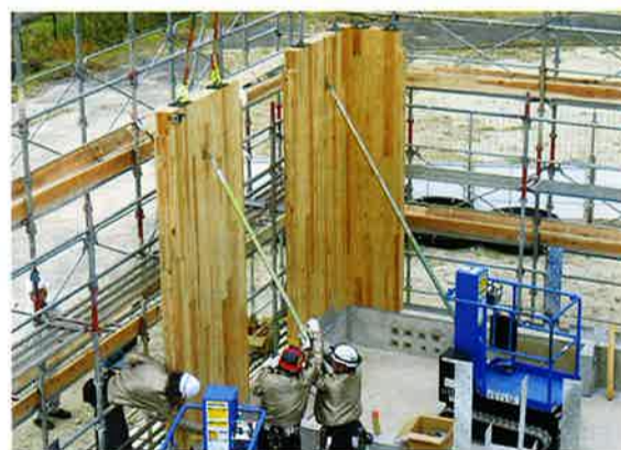
図4 壁パネルを吊り上げ、サポートを設置して施工
